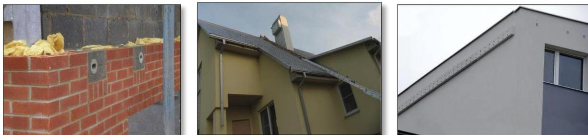
Divers exemples de gîtes encastrés pour martinets : gîte parpaing, gîte sous avancée de toit, nichoir-boîte semi-encasté
