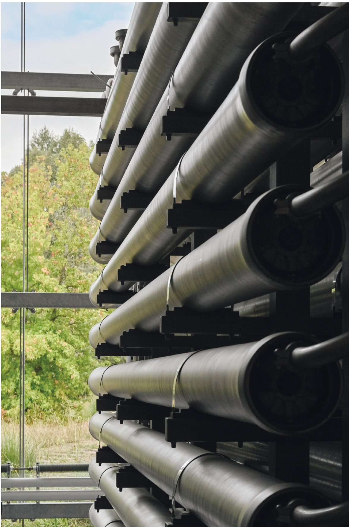
Les membranes de nanofiltration à l'usine de production de Méry-sur-Oise
